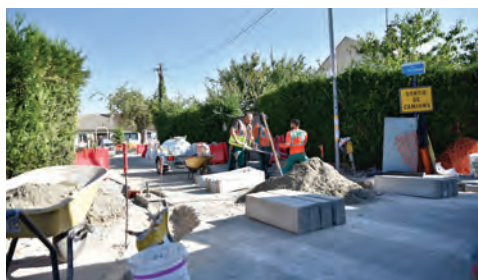
Allée des pivoinés, dans le quartier du Village Parisien, la Ville refait totalement la voirie. Ici, la pose de bordures séparant les trottoirs de la chaussée. Viendra ensuite la pose des nouveaux enrobés. Coût des travaux : 140 000 €.
