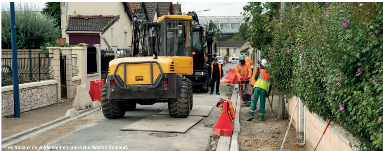
Les travaux de voirie sont en cours rue Gaston Roulaud.
