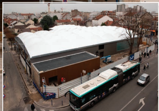
La halle provisoire du marché, en construction.
