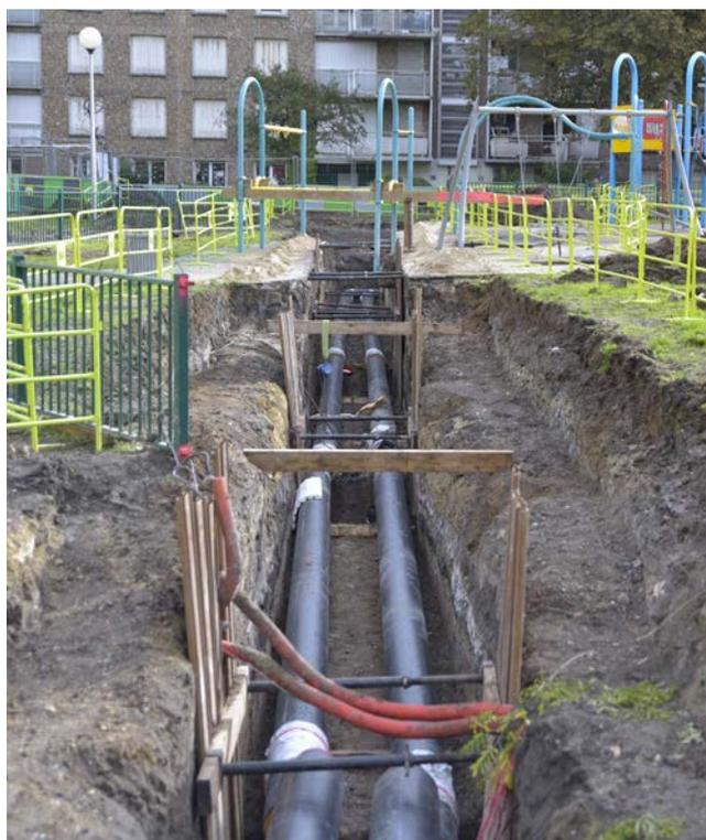
*Le quartier du Petit Drancy est en train d'être raccordé à la chaufferie du réseau de géothermie. Des tranchées ont dû être réalisées à l'intérieur de l'aire de jeux et du city park pour accueillir les canalisations. Tous deux seront remis en état par l'entreprise à l'issue des travaux.*
