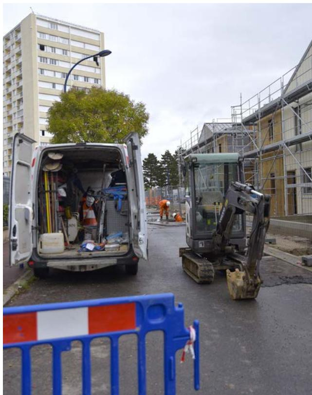
*Le premier programme de renouvellement urbain se termine dans le quartier Auffret/Cachin. Rue Lino Ventura, les travaux de raccordement des 13 maisons en bois aux différents réseaux ont débuté fin septembre. Suivra la pose de l'enrobé sur la chaussée et les trottoirs. Les travaux devraient être terminés dans le courant de la deuxième quinzaine de décembre.*
