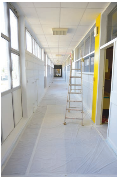
Réfection de la peinture dans les étages de l'école Salengro/Voltaire
