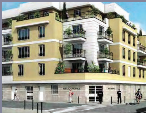
Poste de police municipale.
