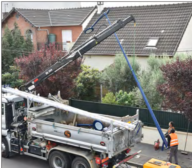
Avec une petite grue, les ouvriers orientent le candélabre afin de le positionner.
