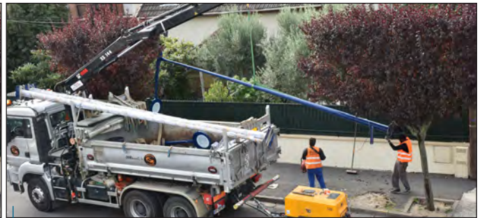
Avec une petite grue, les ouvriers orientent le candélabre afin de le positionner.
