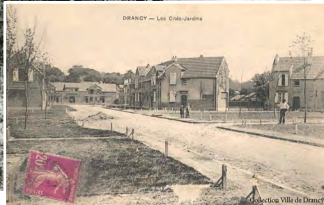
Drancy cité- jardin 27 La cité-jardin, ici rue Jacques Soubiran, construite dans les années 20. Un nouvel habitat pour une nouvelle ville.
