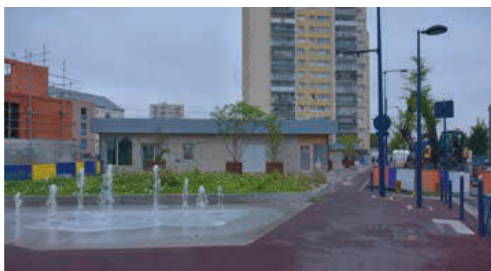
Sur le côté du centre commercial, à l'angle de la rue Victor Schœlcher, une nouvelle agence de l'OPH a ouvert en juillet, une maison des services publics et La Poste ouvriront au début de l'automne.
