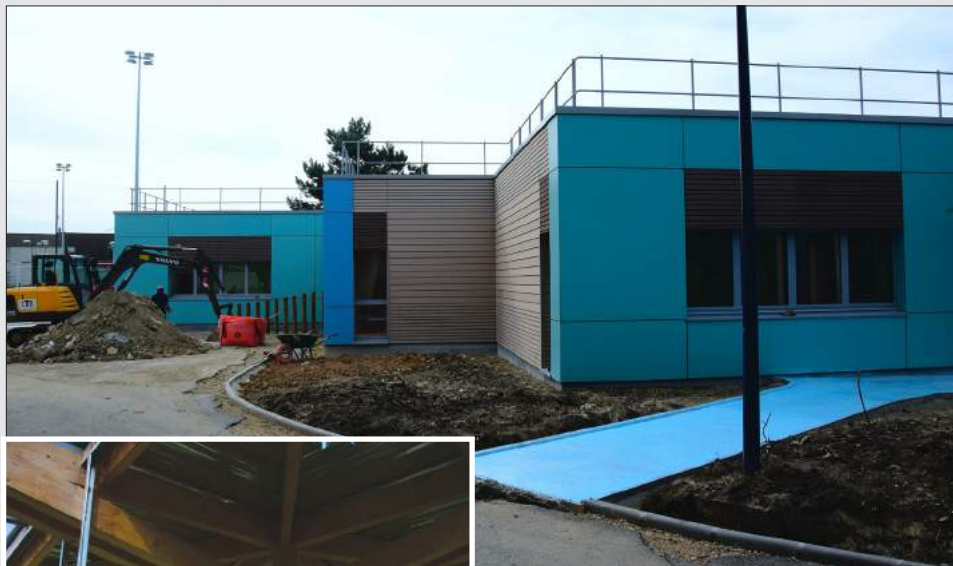
L'extension du bâtiment.
