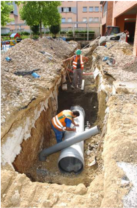
Début d'un énorme chantier d'assainissement dans les rues de Drancy.
