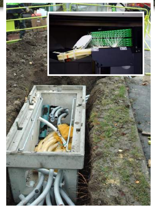
Installation de la fibre optique pour les services municipaux et la vidéosurveillance.
