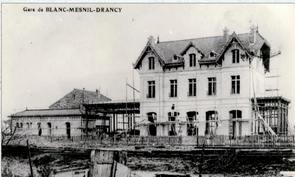
La gare de Drancy - Le Blanc-Mesnil, lors de sa construction en 1912.
