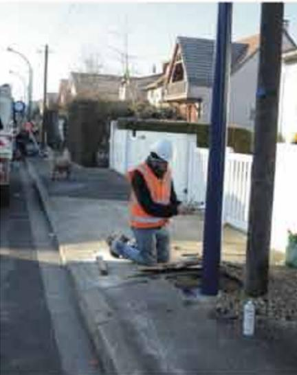
Une fois mis en place, le nouveau candélabre est raccordé à l'électricité. Une coulée de béton tout autour viendra finaliser la pose.
