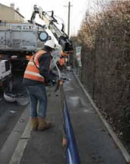
Une sangle est attachée autour du candélabre afin de pouvoir le mettre en place.
