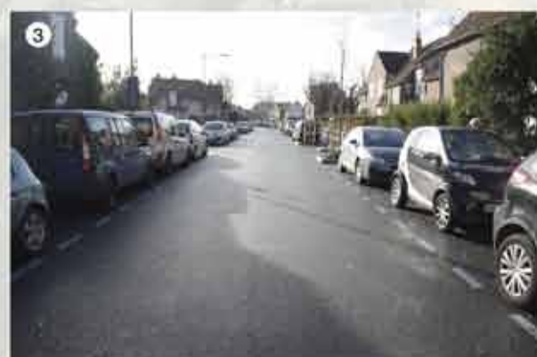
Rue Soubiran Réfection de la chaussée pour un montant de 515 500 €.
