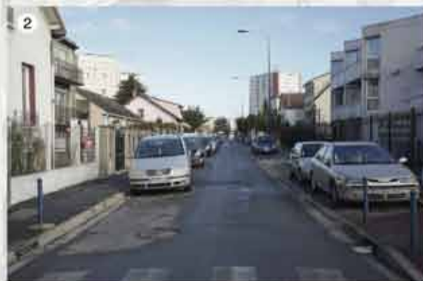
Rue Jules Auffret Travaux d'assainissement pour un montant de 572 000 €.
