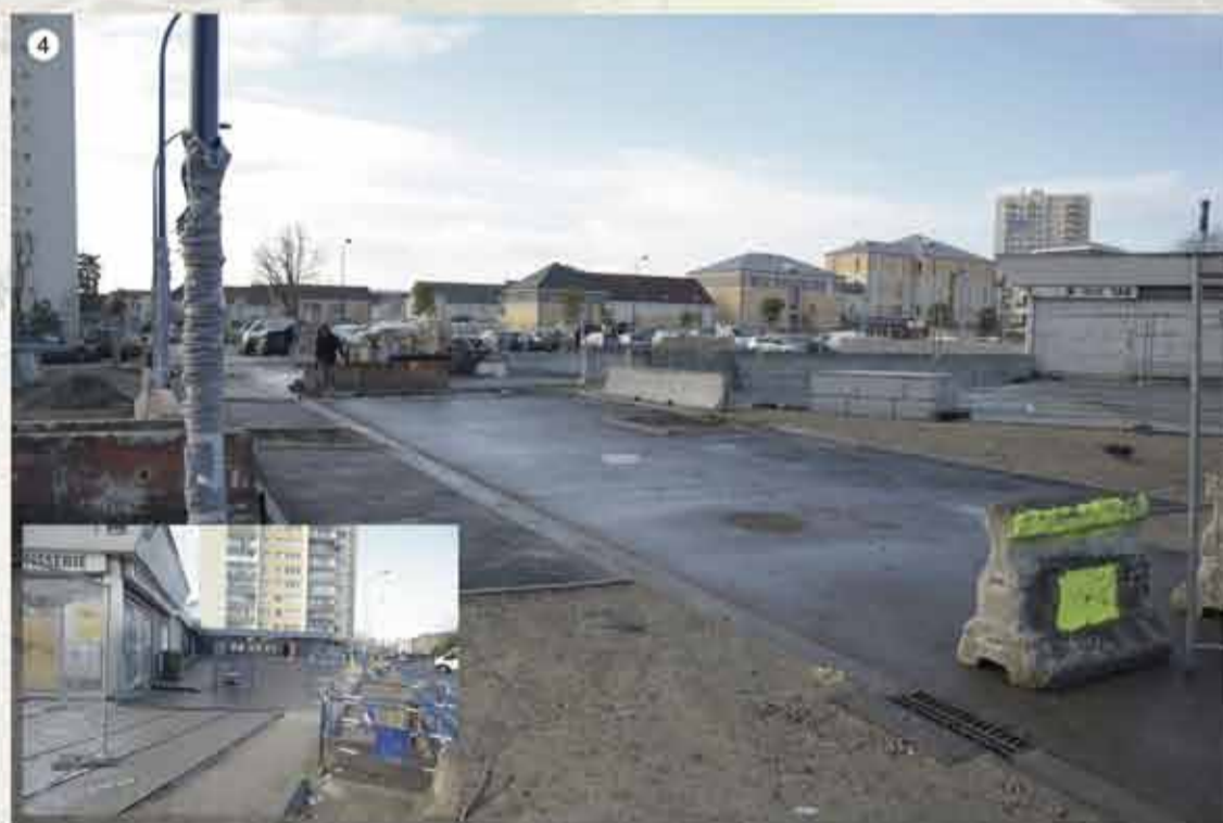
Rénovation urbaine Jules Auffret Réfection de la placette devant les commerces de la rue des Bois de Groslay. Les travaux ont commencé début septembre, ils seront terminés mi-avril. Coût des travaux : 680 000 €.
